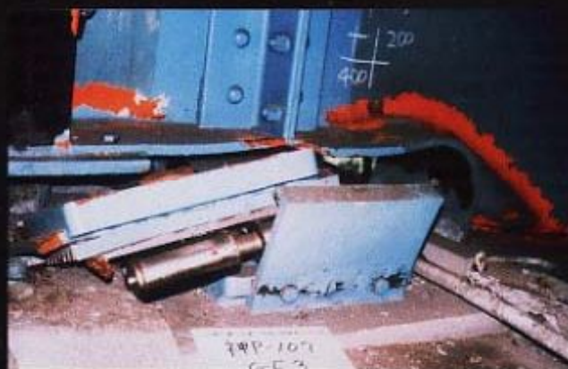
ローラー支承の上歯の逸脱 Deviation of upper shoe
